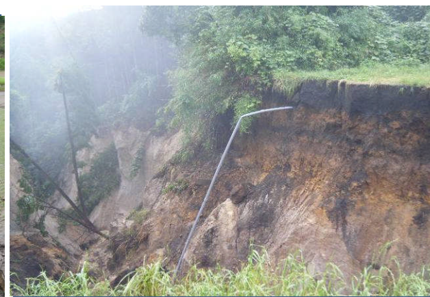
曾於市末吉町の畑地かんがい用の管水路が寸断したため、仮配管により用水を確保しよう助言・指導。(グレー色のパイプが被災した畑地かんがい水路)
