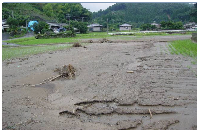
霧島市霧島町湯之宮地区の河川から水田への土砂流入による被災状況
