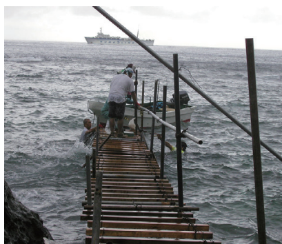
図1 設置した栈橋
