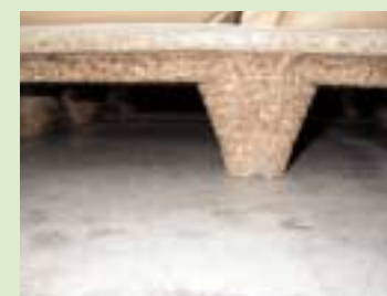
③采用硬质纤维板(particleboard)的垫木
