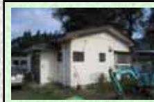
定住促進のための空き屋等の改修
