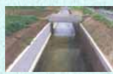
農業用排水路の整備
