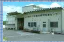
特用林産物生産施設の整備
