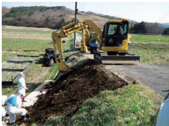
法面の除染状況
