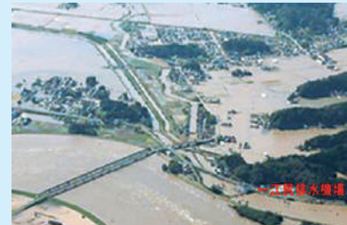
令和元年東日本台風（台風19号） 江尻排水機場周辺湛水状況
