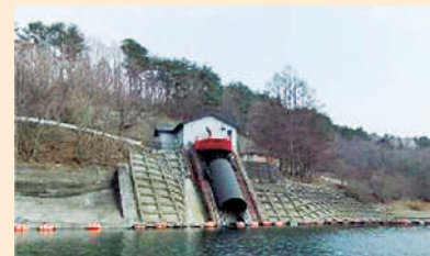
羽鳥ダム取水設備経年劣化の進行
