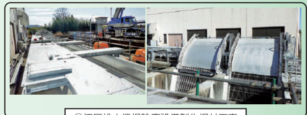
④江尻排水機場除塵設備製作据付工事
