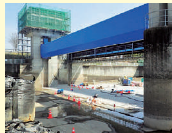
ゲートの塗装
