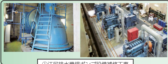
①江尻排水機場ポンプ設備補修工事
