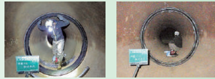
止水バンドの設置
