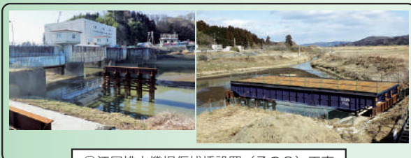
③江尻排水機場仮棧橋設置（その2）工事
