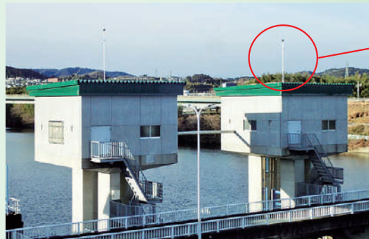
頭首工操作室屋上に設置した抑制型避雷針
