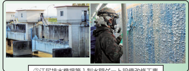
②江尻排水機場第1制水門ゲート設備改修工事
