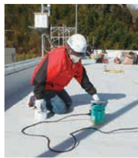
【建屋改修】防水工事作業状況
