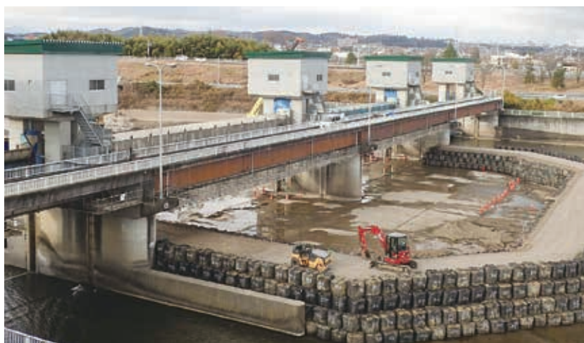
【仮締切工完了_R2.11.26】
