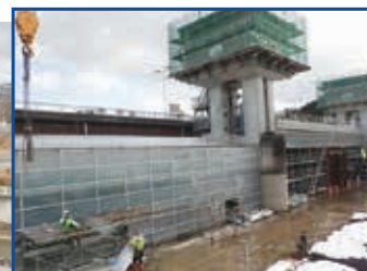
【ゲート仮囲い設置状況_R2.12.21】
