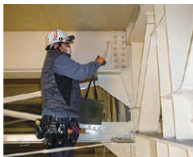
【鉄骨工事作業状況】
