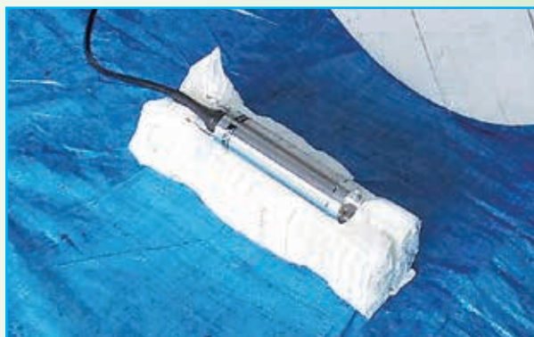
【水位計の改修（羽鳥）】
