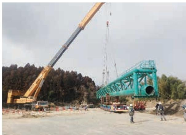
【①大型クレーン550 t 級による水管橋吊上げ状況】
