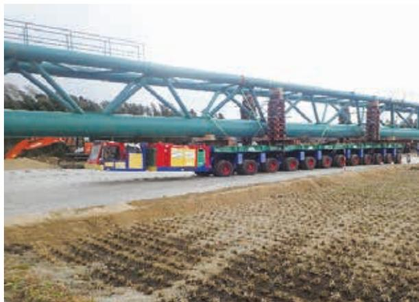
【②多軸台車による水管橋移動状況】
