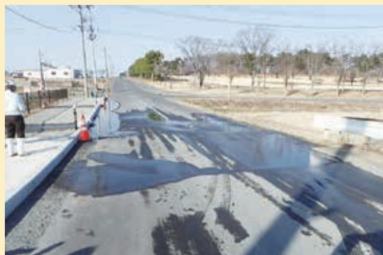
【路面への漏水】
