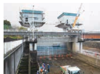
【ゲート仮囲い設置状況 R3.11.24】
