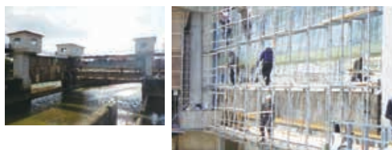
第3第4制水門ゲート設備改修工事
