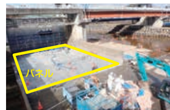
【土砂吐エプロン補修工 (パネル設置後充填工) 状況_R4.02.01】
