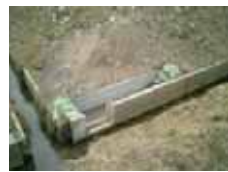
【ワンド工】 （延長：2m、幅：0.4m）
