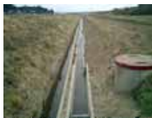
【副水路工】 （延長：108m、幅：0.3～0.4m）
