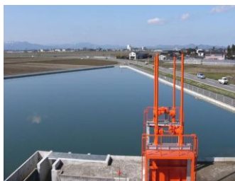
写真-1 八栄島第2ファームポンド全景
