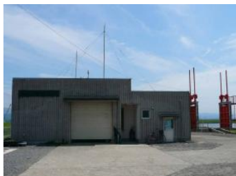
写真-2 八栄島第2用水機場全景
