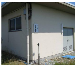
写真-2 第7加圧機場
