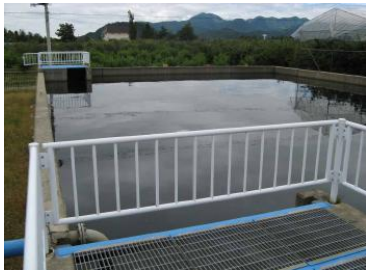
写真-1 第7ファームポンド全景
