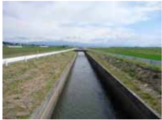
右岸幹線用水路
