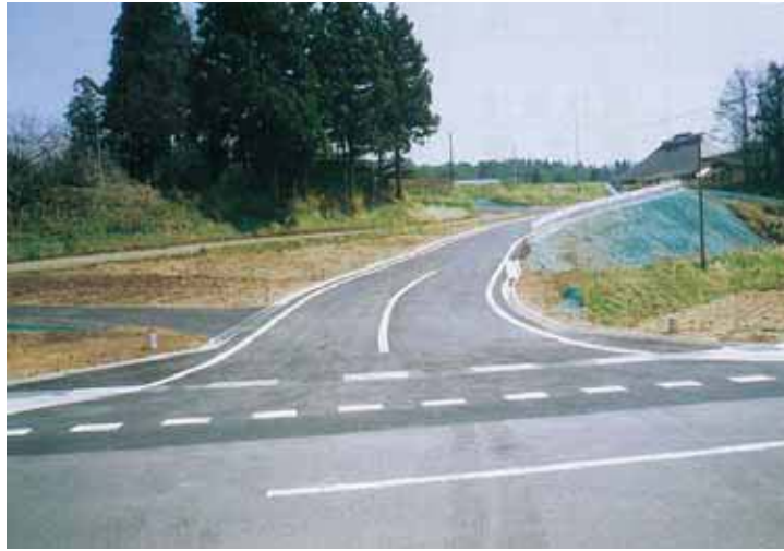
関連事業（経営体育成基盤整備事業）により整備された農業集落道 （写真提供：岩手県）
