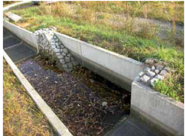
脱出用スロープ
