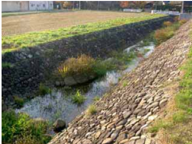
石積みブロック
