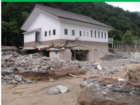
集落排水処理場の浸水被害 （八木沢地区）
