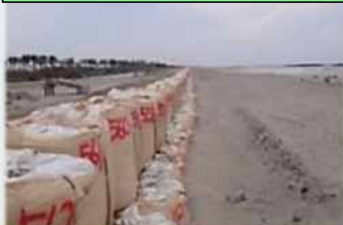
仮締切堤の設置
