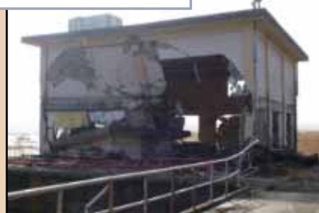
損壊した排水機場
