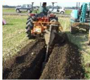
暗渠排水の整備
