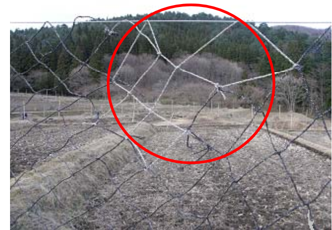
防護網の補修(上記赤丸が補修箇所)
