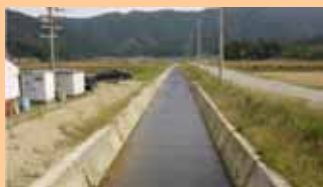
[三面コンクリート張りの水路]
