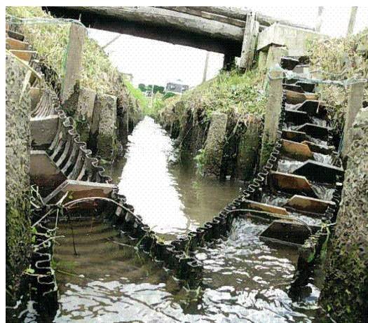
水田魚道の設置
