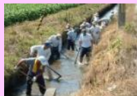
水路の泥上げ
