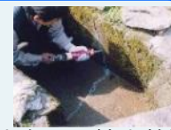
水路のひび割れ補修
