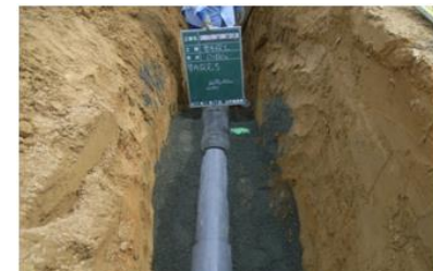
塩ビ管への布設替状況
