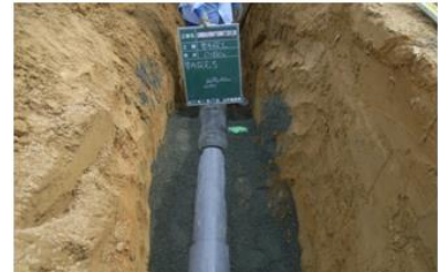
塩ビ管への布設替状況
