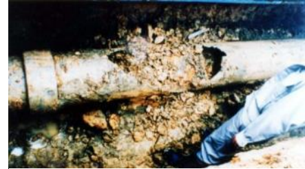
石綿管破損状況
