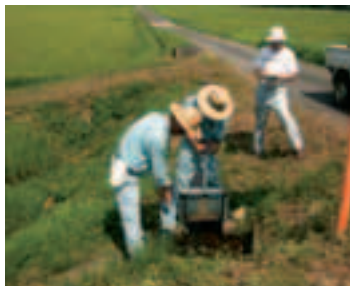
施設の保守管理
