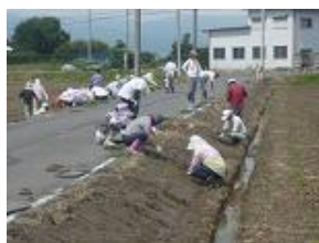
芝の植栽状況
