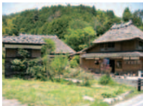
茅葺屋敷を利用した都市農村交流施設
