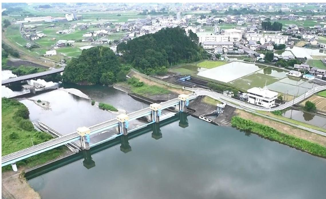
写真は、岐阜県南西部の揖斐川にある取水施設「岡島頭首工」をドローンで撮影したものです。岡島頭首工は、大垣市外6町にまたがる農地約5,000haに安定的に用水供給を行っており、地域では水稲を中心に水田の畑利用による小麦、大豆等を栽培する土地利用型農業とブロッコリー、柿等の高収益作物を組み合わせた農業が展開されています。
