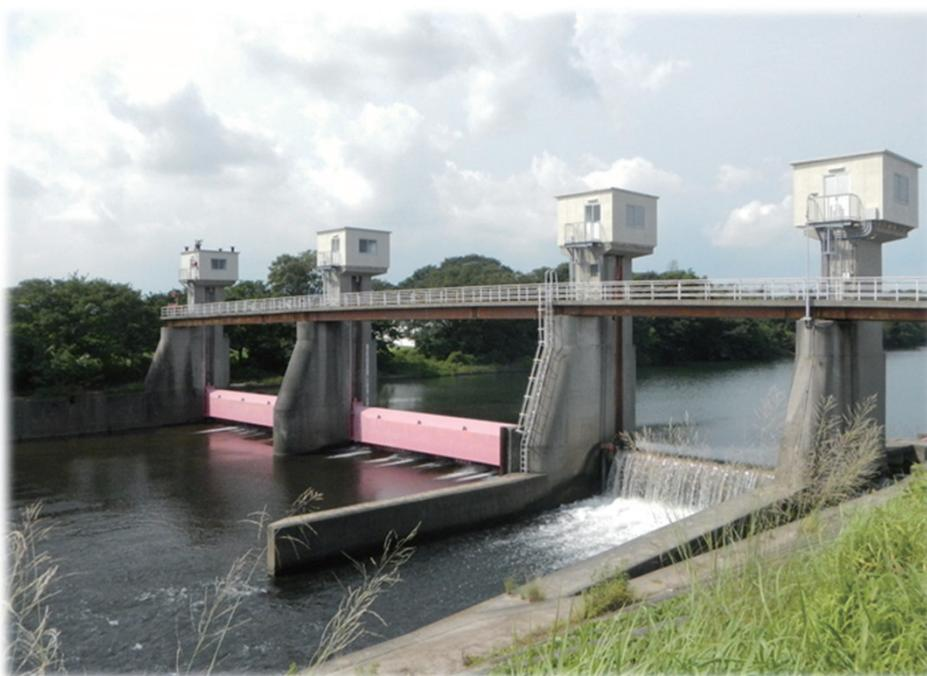
写真は、国営矢作川第二農業水利事業（昭和38～53年）にて造成された乙川頭首工。岡崎市中心部を流れる乙川と矢作川の合流点附近に位置し、岡崎市南部及び西尾市の約3,200haをかんがいするための取水施設です。
