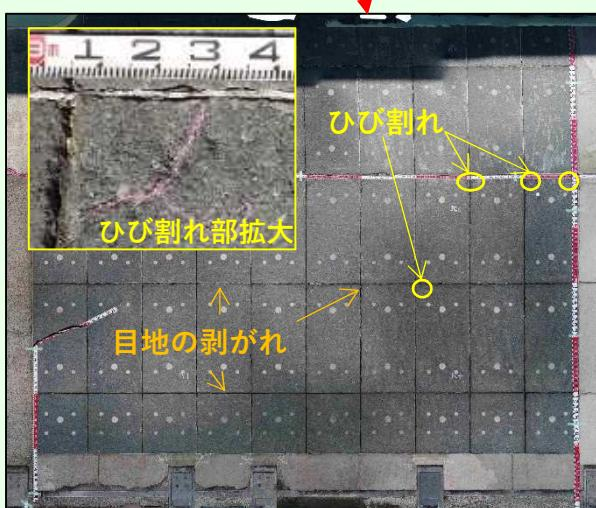
写真2. 高強度プレキャストコンクリート版工法 供用10年目の状況
