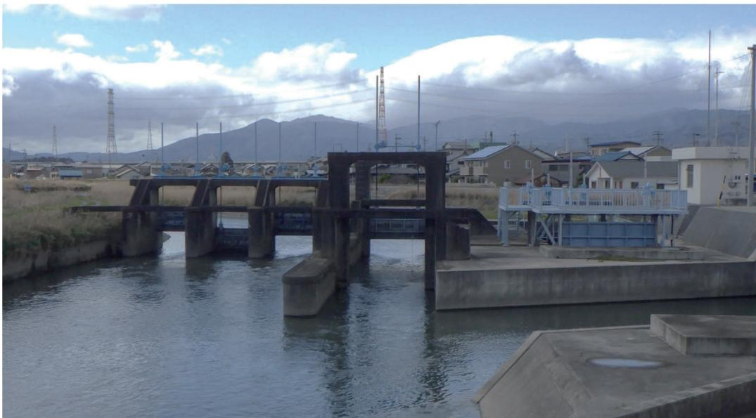
写真の「福田頭首工」は、木曽川水系揖斐川支川杭瀬川に位置し、昭和9年度に杭瀬川改修工事により既存取水堰に替わり築造され、以後、昭和43～58年度に実施された国営かんがい排水事業「西濃用水地区」により改築されている。
