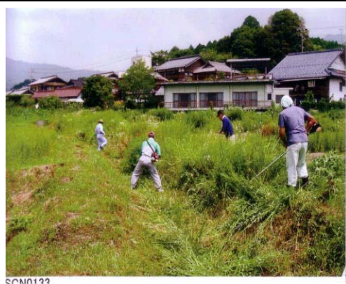
〈水路整備〉 水路周辺の草刈り
