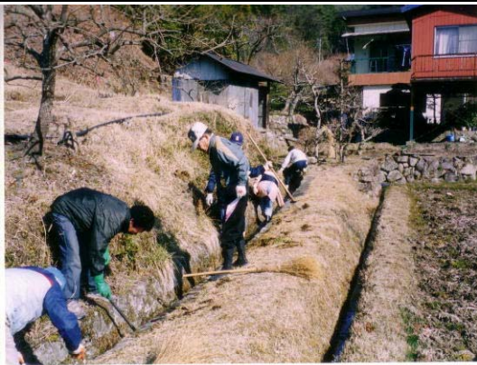
〈水路整備〉 水路の土出し・目地埋め
