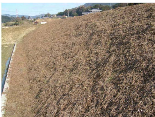
法面被覆植物の植栽状況
