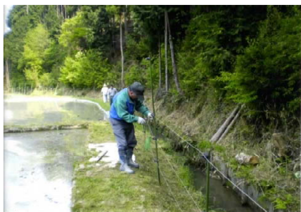
電気柵の設置の様子
