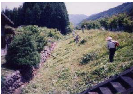
法面の草刈り
