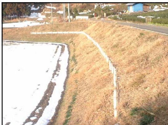
法面中段の足場
