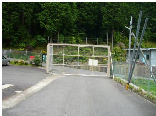
出入口は獣害対策用電気柵を設置
