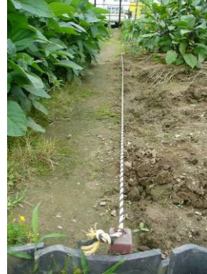
杭とトラロープで区画割り
