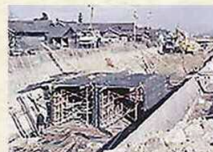
明治幹線管水路工事(安城市里町)
