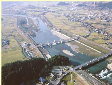
揖斐川より農業用水を取水する施設、岡島頭首工
