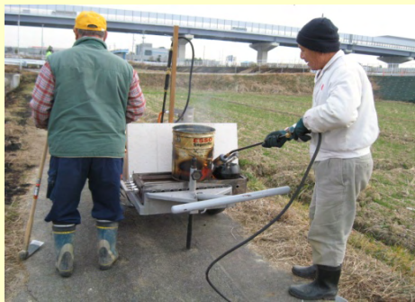
農道(亀裂)補修の様子
