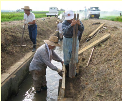
水路補修の様子
