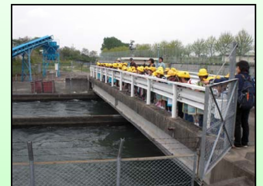
宮田導水路と除塵機
