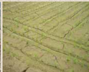
水田の地割れ状況 2005.5.12
