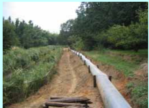
仮返し水路設置状況
