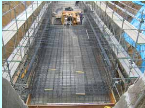
鉄筋組立作業状況
