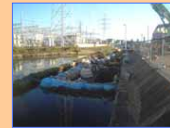
工事中の降雨排水を仮廻すための準備をしています
