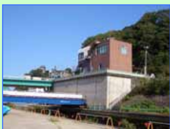
既設の頭首工操作室(鉄筋コンクリート造2階建)
