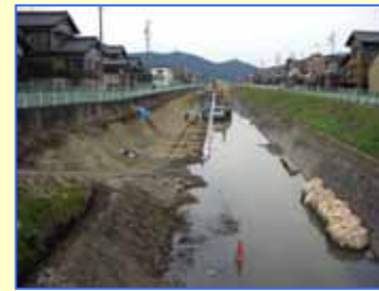
工事中の仮廻し用水路の設置しています
