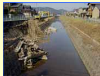
既設のブロック積み水路を取り壊しています
