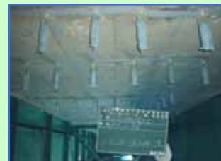
操作橋クラックの補修状況
