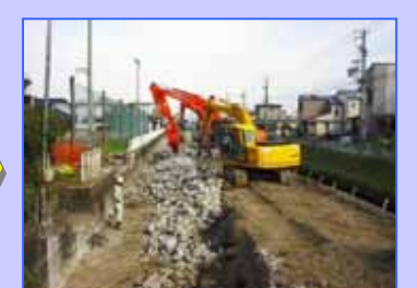
既設のコンクリート水路を取り壊しています
