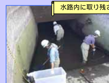
救出作業開始です
