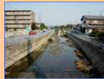
工事用車両が進入するための仮設道路を設置しています
