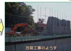
改築工事のようす
