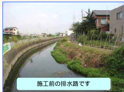
大江排水路工事
