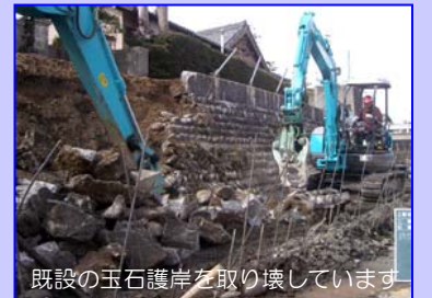
既設の玉石護岸を取り壊しています
