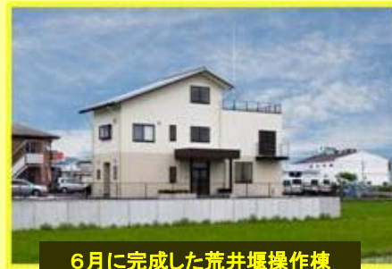
6月に完成した荒井堰操作棟
