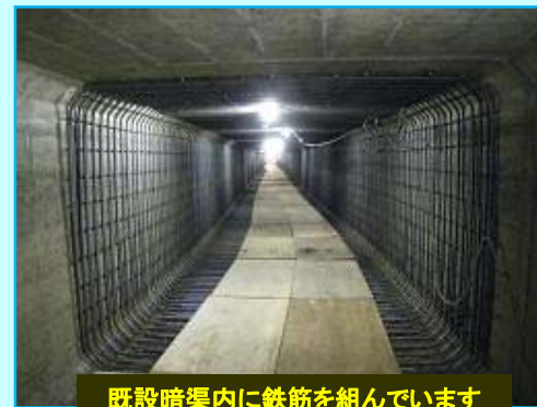
既設暗渠内に鉄筋を組んでいます
