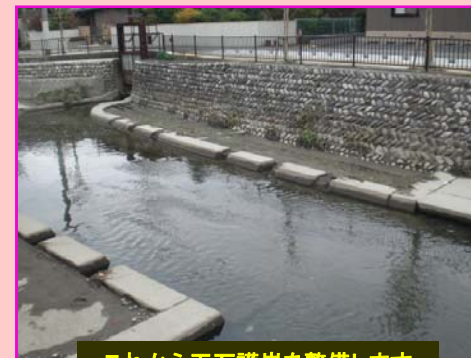
これから玉石護岸を整備します
