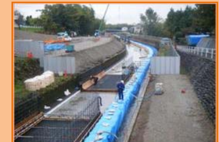
暗渠化する水路の鉄筋組立をしています
