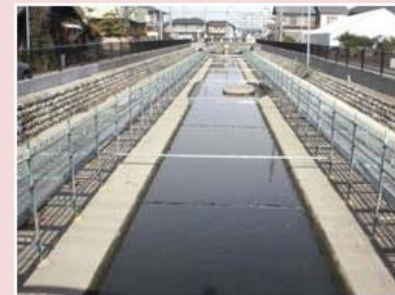
工事のための足場を設置しました。
