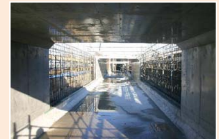
手前部分がボックスカルバート（暗渠化）完成済みです。
