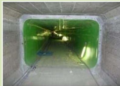
既設水路が補強されました。
