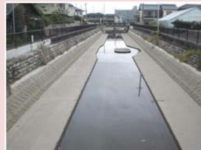
水路上部の玉石積みを整備します。
