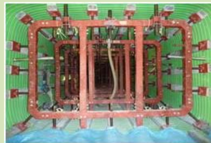
更正管を支える支保工の設置状況
