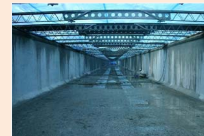
導水路側壁の表面被覆が終わり、この後、底版を施工します。
