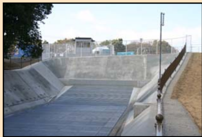
本体工事完了
