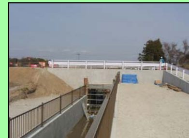
四ツ谷暗渠完成
