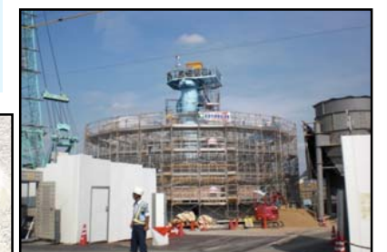
到達立坑の施工状況。詳しくは次号を!
