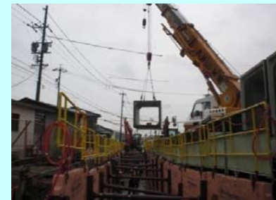
側水路設置状況
