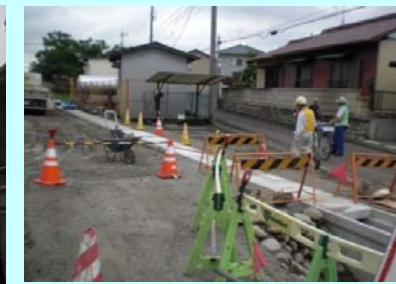
側溝設置状況
