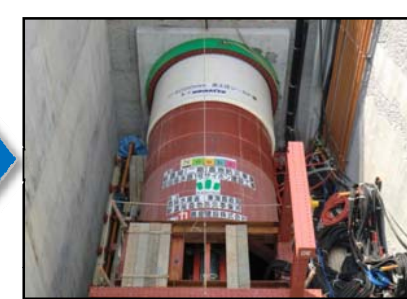
約10ヶ月かけて着実に掘り進みます。
