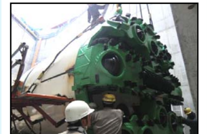
シールド機の顔! 直径約4m
