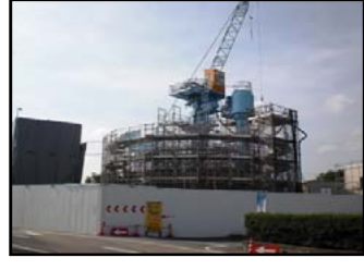
施工中 到達立坑
