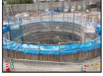
施工中 到達立坑
